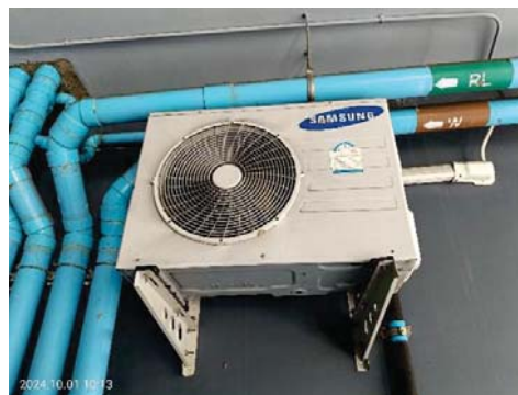
ระบบปรับอากาศแบบแยกส่วน
